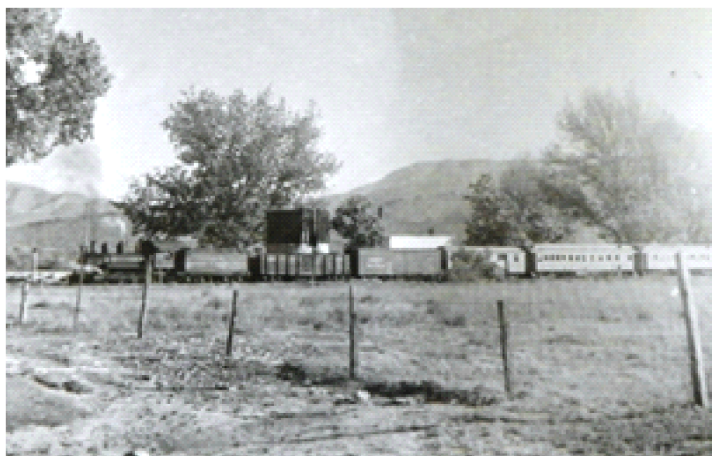
Edificio de la estación de La Encantada, y panorámica de la estación con el tren No 1.
